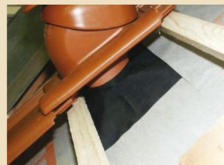
6. Установление керамический вентиляционный комплект с использованием уплотнительной ленты
