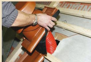
3. Керамическую трубу, проходную черепицу, флекс-шланг и уплотнительную ленту зафиксируйте как единый кусок на жерло. Ленту положите на сторону у гребня и заклейте клеем.
