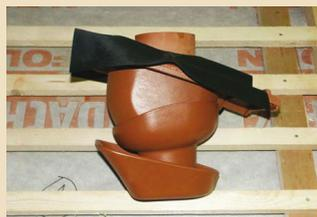
1. Керамическую вентиляционную трубу поставьте вместе с проходной черепицей. Вентиляционную трубу с проходной черепицей поставьте наоборот и уплотнительную ленту протяните через керамическую трубу.
