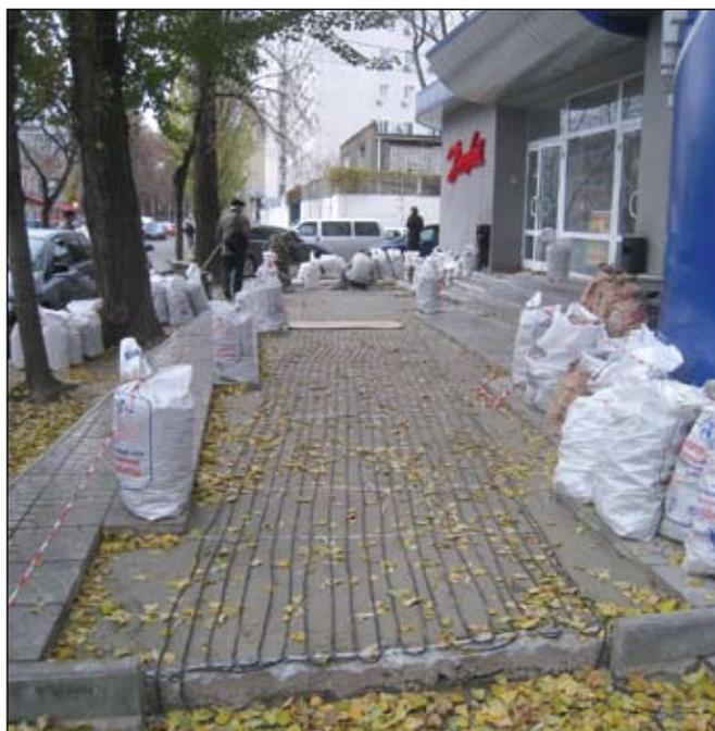
Таким образом, при удельной мощности в 360 Вт/м<sup>2</sup> и общей площади обогрева 31 м<sup>2</sup>, суммарная мощность нагревательной системы составила 11,3 кВт, а длина нагревательных кабелей – 420 метров.
