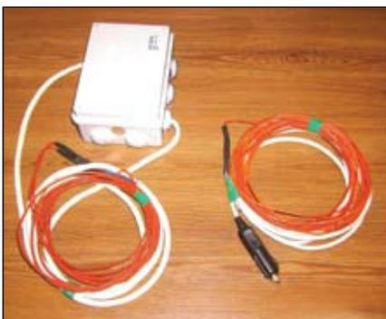
Всего обогрето восемь бочек на базе автомобиля и восемь – на прицепах. Установленная мощность каждой системы составила 36,5 Вт при удельной мощности 10 Вт/м.
