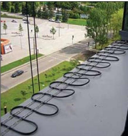
Система защиты от намерзания снега и льда на кровле и ступенях центра «Центавр Плаза-2» (Компания «Свет и Тепло», г. Донецк)
