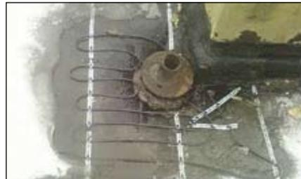
Система защиты от намерзания снега и льда на кровле профилактория «Вдохновение» (Компания «Свет и Тепло», г. Донецк)
