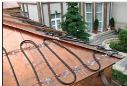
Система защиты от намерзания снега и льда на мягкой кровле (Компания «Свет и Тепло», г. Донецк)
