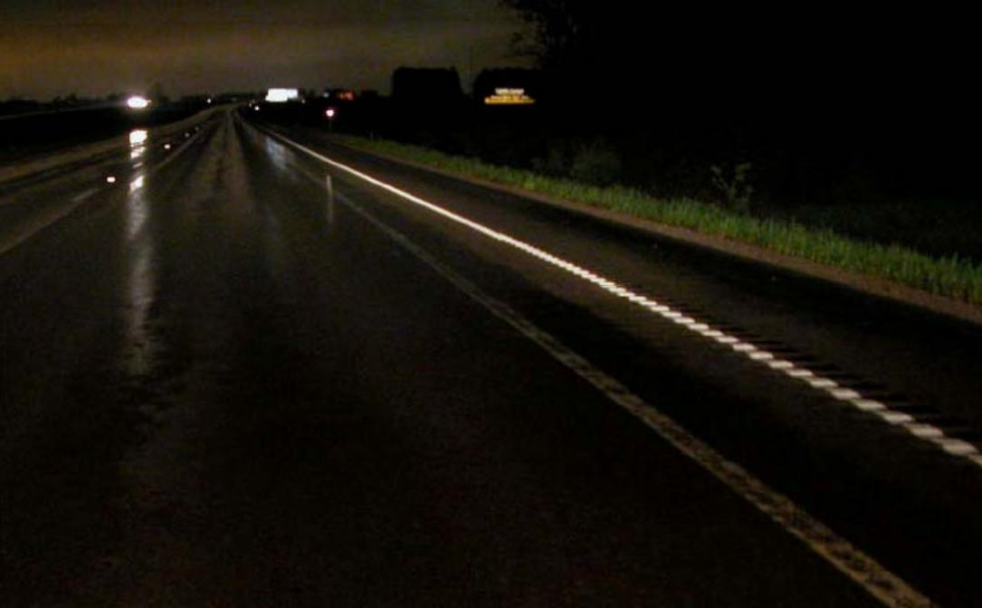
**Эксперимент проведенный Департаментом Транспорта США определил светоотражающий эффект двух линий после 1-ой зимней эксплуатации:**
