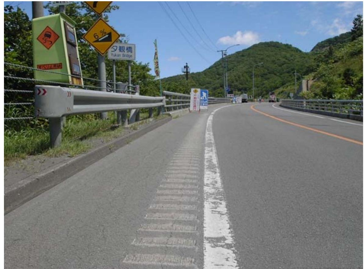
Устройство шумовых полос на автодорогах в Японии осуществляется как на укрепленной обочине так и по сплошной разделительной линии, что позволяет снизить количество столкновений со встречным транспортом до **55%**
