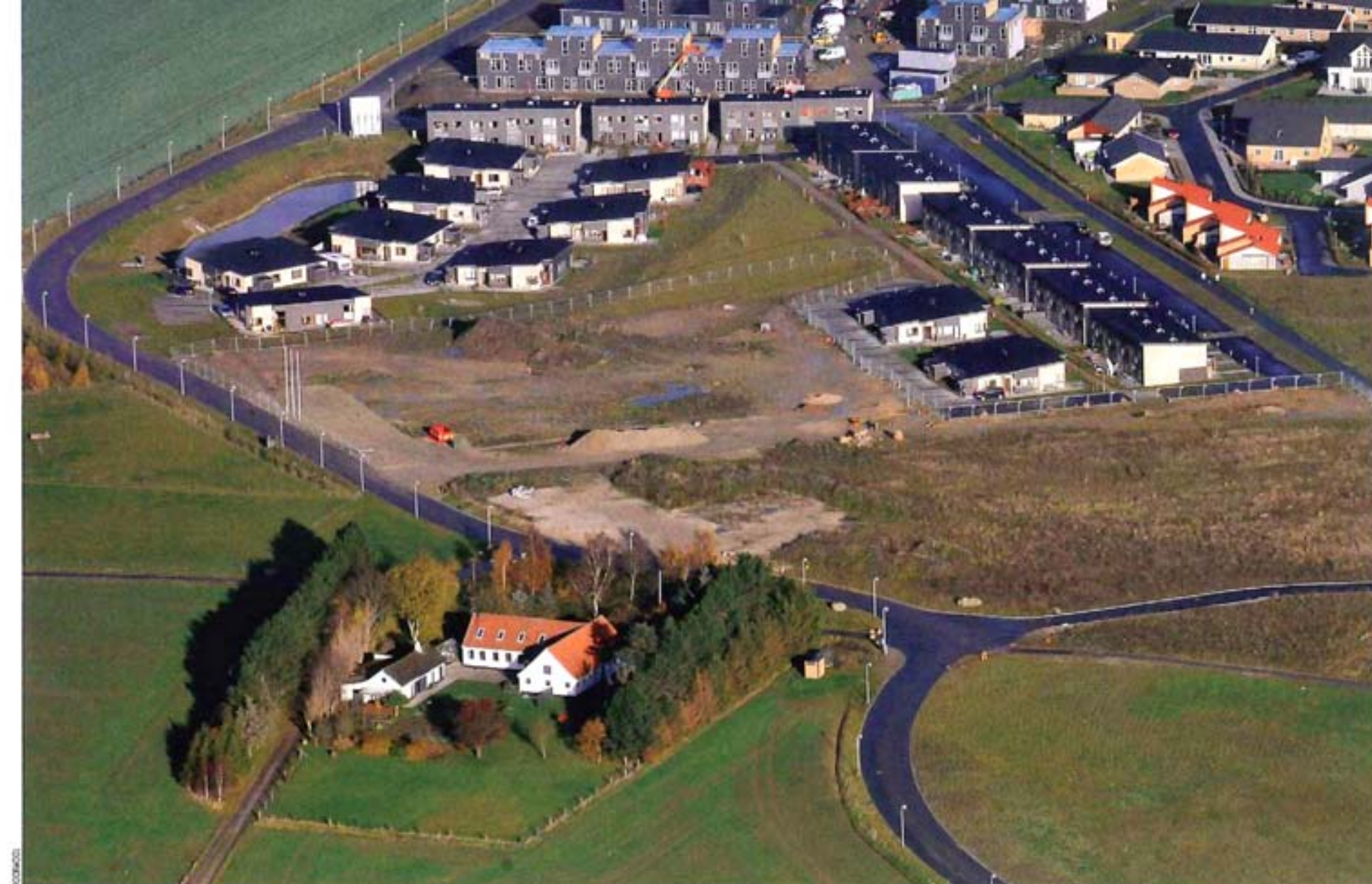
Под крышами домов в маленьком Южном Стенлесе скрываются большие энергосберегающие амбиции
